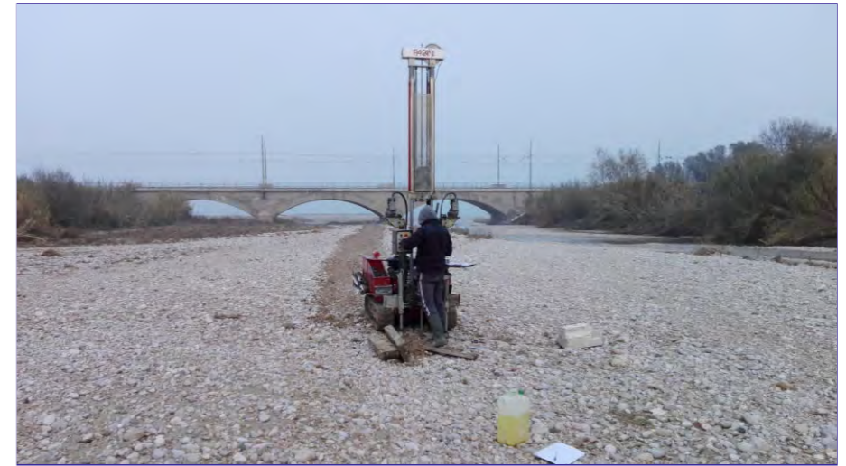
Foto 3 - Esecuzione prova penetrometrica dinamica DPHS (P3)
