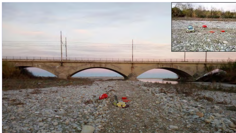
Foto 7 - Ubicazione ed esecuzione prova sismica (Tr2) mediante metodologia HVSr
