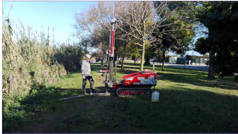
Foto 1 - Esecuzione prova penetrometrica dinamica DPHS (P1)
