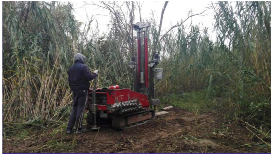
Foto 2 - Esecuzione prova penetrometrica dinamica DPHS (P2)
