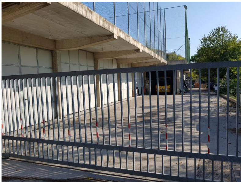
Figura 5.8 – ES 007 - 008 Deposito Mezzi Comunali
