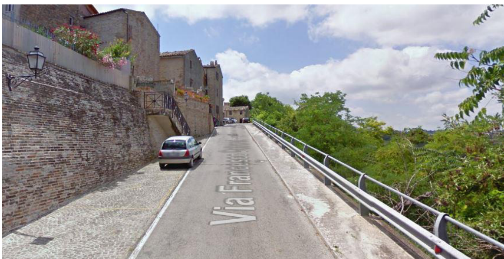
Figura 6.14 – AC 25 Ponte a sbalzo in Via Francesco Petrarca
