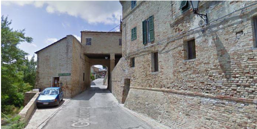
Figura 6.13 – AC 03 Discontinuità in Via Roma
